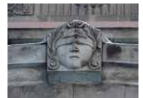
目隠しをした女神像(旧札幌控訴院庁舎)
