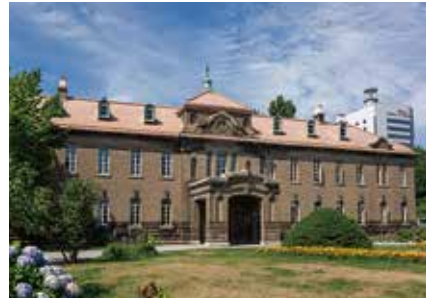
旧札幌控訴院庁舎(札幌市資料館)
